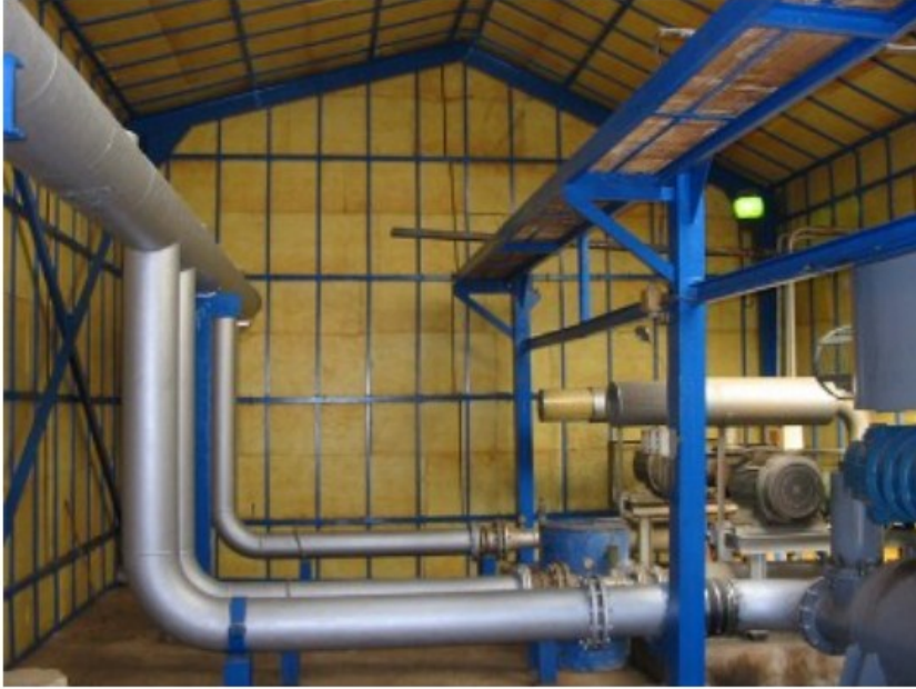
Akkim Kimya San. A.Ş. Yalova Fabrikası Blower ses yalıtım uygulaması
