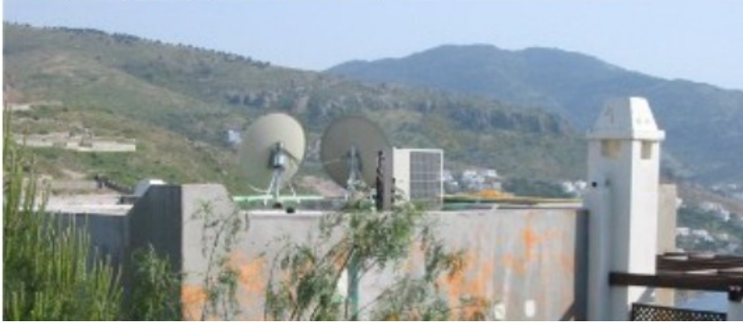
Nejat Önen Villa dıştan ısı yalıtımı yapılması (mantolama)
