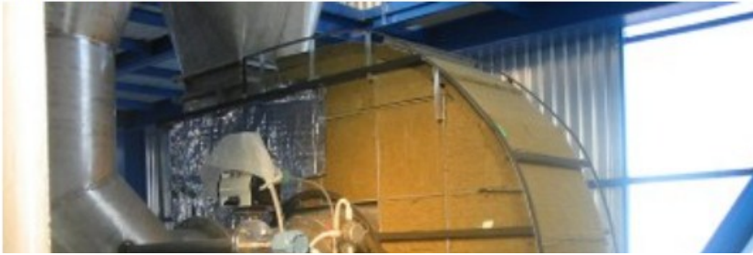
Akkim Kimya San. A.Ş. Yalova Fabrikası SPC tesisi ses yalıtım işleri
