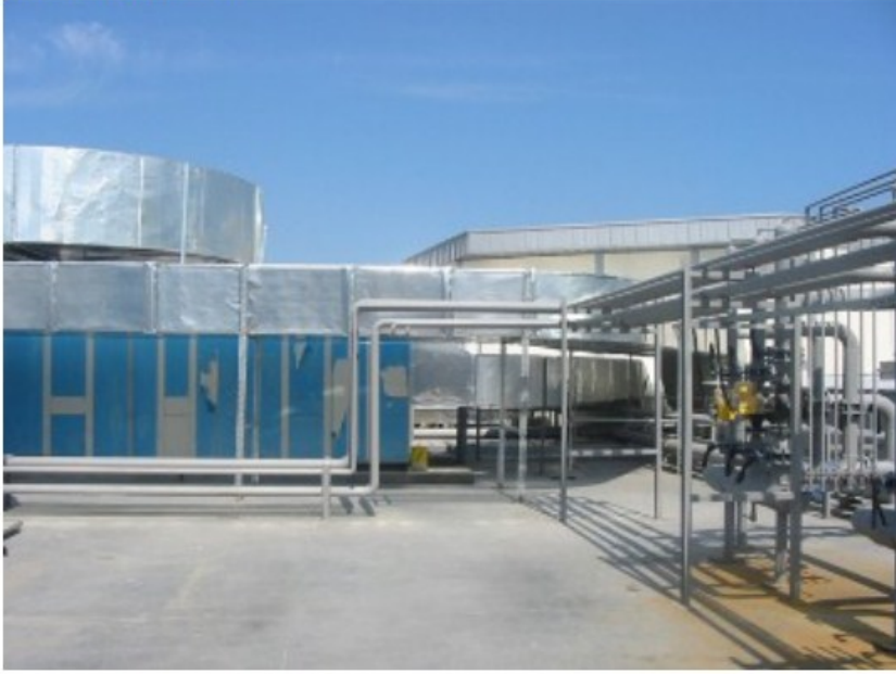
Kale Alışveriş Merkezi Isı Yalıtımı Uygulaması
