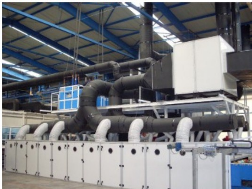
„Тракия Джем Санайи” А. Ш.- Инсталация за автомобилно стъкло Климатични системи в зали за щамповане СН 4
