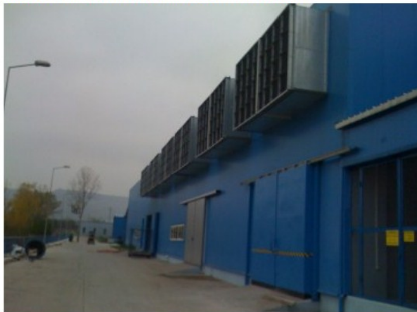
„Тракия Джам Санайи” А. Ш.- Завод за автомобилно стъкло - България Изработка и монтаж на заглушители за вентилаторни зали
