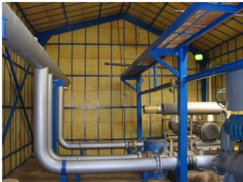
„Акким Кимия Санайи” А.Ш – завод в Ялова Звукоизолация Blower
